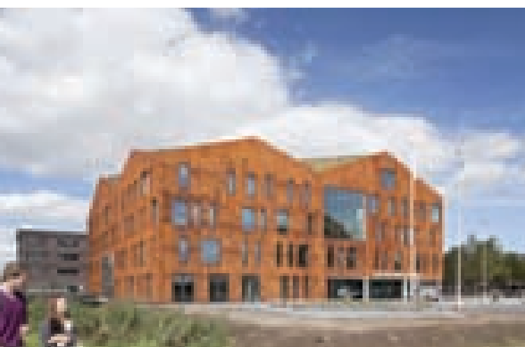
Een landschapje van vier daken met wisselende hellingshoeken is diagonaal, in noord-zuidrichting, op het vierkant van de cortenstalen onderbouw gezet.
