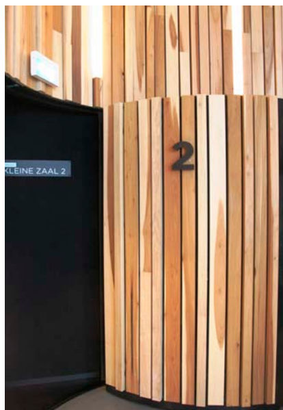
De toegangsdeuren tot de zalen zijn aan weerskanten voorzien van de yellow poplar-latten.
